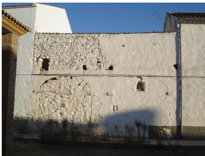
Detalle de los arcos cegados que eran las puertas delanteras para entrar al corral. Foto: F. J. Pérez Fernández, 2010.
