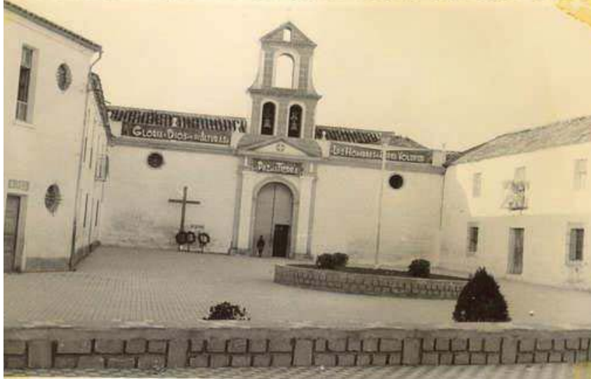
Casa del cura, iglesia de la Inmaculada Concepción y casa del comandante civil de Arquillos. Fuente: desconocida (internet), Medios del siglo XX
