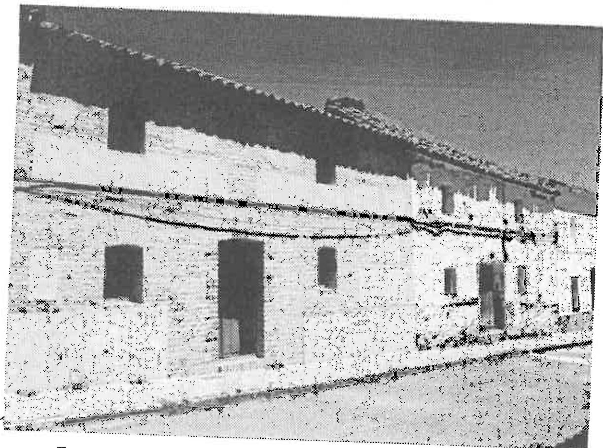
Fotografía N° 3.- Vivienda con la fachada restaurada en Aldeaquemada.
