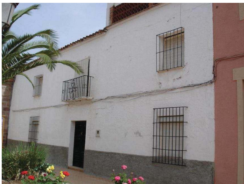
Fachada principal de la casa del comandante civil de Arquillos, convertida en una vivienda particular. Foto: F. J. Pérez Fdez, 2010.
