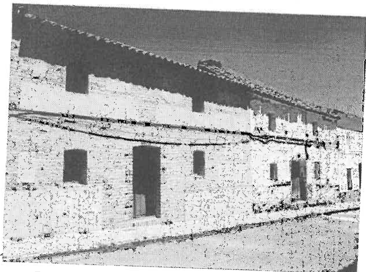
Fotografía N° 3.- Vivienda con la fachada restaurada en Aldeaquemada.
